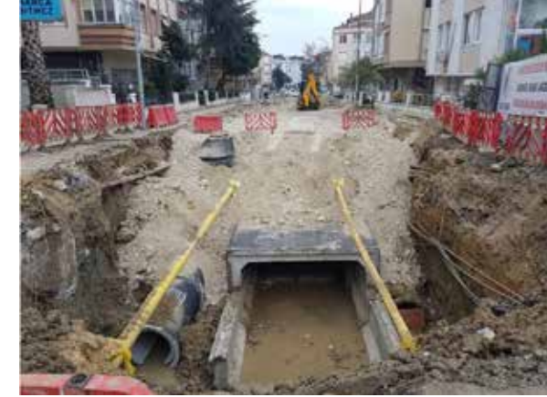
KEMERDERE YAĞMURSUYU HAT ÇALIŞMASI
