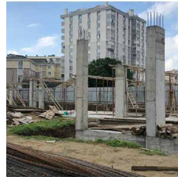
AYŞEN GÖREN – GÜLSÜM UÇAR EĞİTİM TESİSİ İNŞAATI
