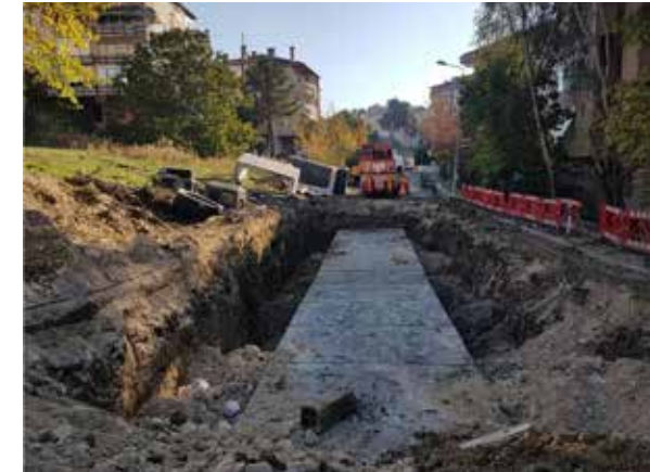
SERİNPINAR YAĞMURSUYU HAT ÇALIŞMASI.
